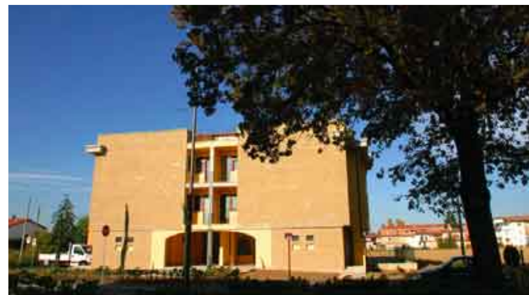
Sopra e in alto a sinistra due edifici per 32 alloggi in Comune di Scandicci, loc. Badia a Settimo, realizzati fra il 2000 e il 2003 ed assegnati recentemente
