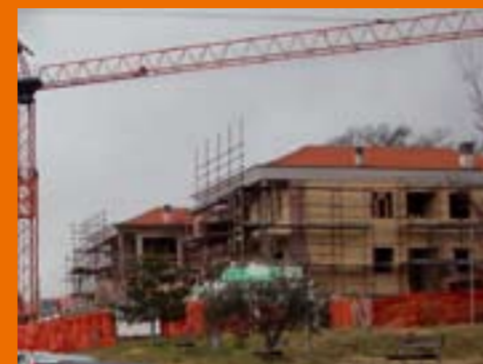
SAN CASCIANO VAL DI PESA, SAN PANCRAZIO 12 alloggi - Impresa: CEAC S.r.l. di Napoli - ultimazione lavori a termini contrattuali: maggio 2007
