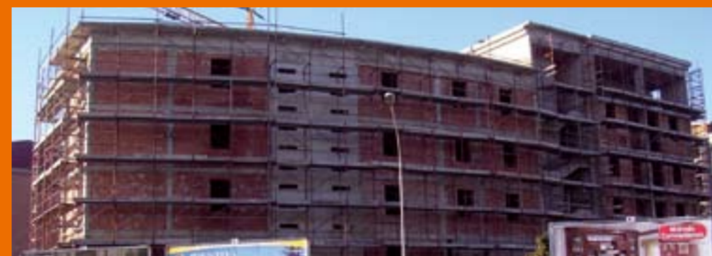
FIRENZE, PRU S. MARIA A CINTOLA, LOTTO N. 6 26 alloggi - Impresa: Desama S.a.s. di Napoli - ultimazione lavori a termini contrattuali: febbraio 2007
