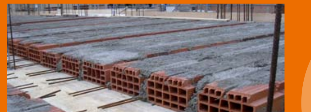
SIGNA, S. MAURO 18 alloggi - Impresa: CO.GE.STRA. S.a.s. di Marcanise (CE) - ultimazione lavori a termini contrattuali: dicembre 2007
