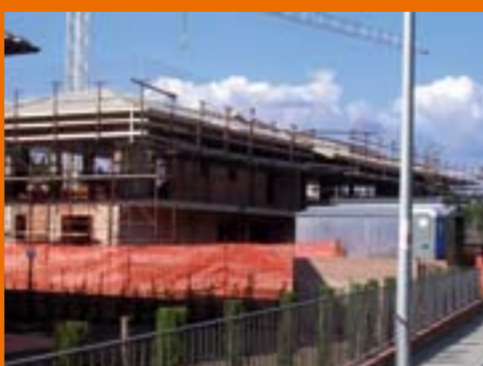
IMPRUNETA, SASSI NERI 12 alloggi - Impresa: Apicella Tonino S.r.l. di Salerno - ultimazione lavori a termini contrattuali: giugno 2007
