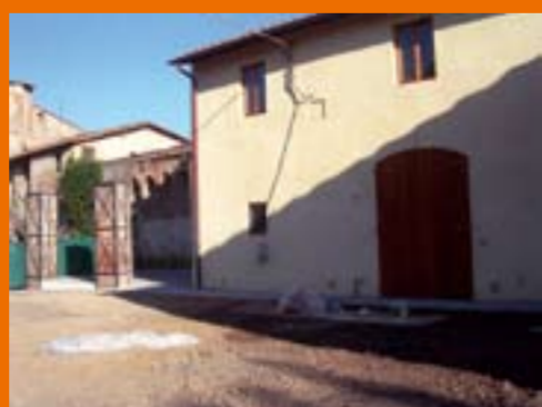
LASTRA A SIGNA, CASCINA PINUCCI 3 alloggi - Impresa: Oplonde S.a.s. di Firenze - ultimazione lavori a termini contrattuali: dicembre 2007
