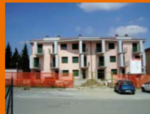
GAMBASSI TERME, BELVEDERE 18 alloggi - Impresa: CAMI S.r.l. di Poggibonsi (SI) - ultimazione lavori a termini contrattuali: dicembre 2006
