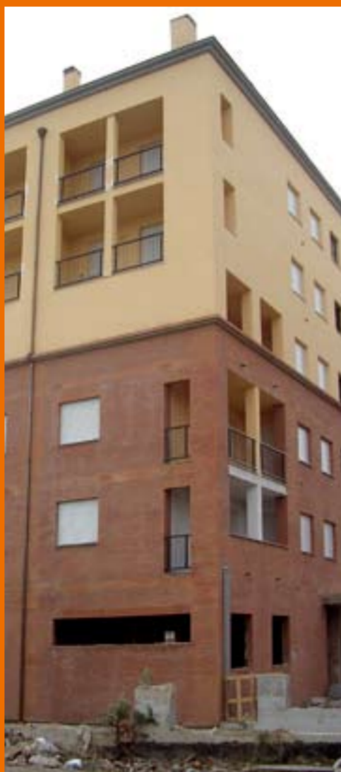
FIRENZE, PUR EX GOVER 52 alloggi - Impresa: Delfino Costruzioni S.r.l. di Napoli - ultimazione lavori a termini contrattuali: febbraio 2007
