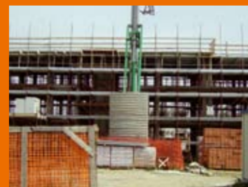
FUCECCHIO, S. PIERINO 12 alloggi - Impresa: CAMI S.r.l. di Poggibonsi (SI) - ultimazione lavori a termini contrattuali: luglio 2007
