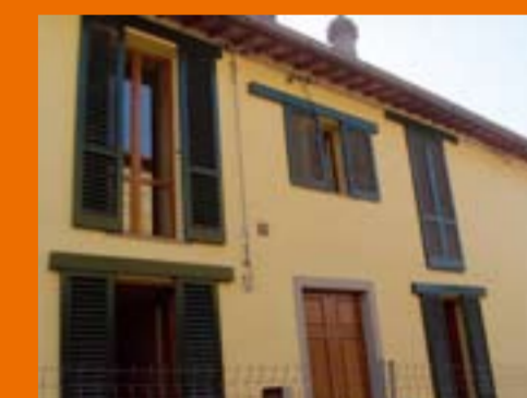
VINCI, EX SCUOLA VIOLINI 5 alloggi - Impresa: MI.PE. di Firenze - ultimazione lavori a termini contrattuali: dicembre 2006
