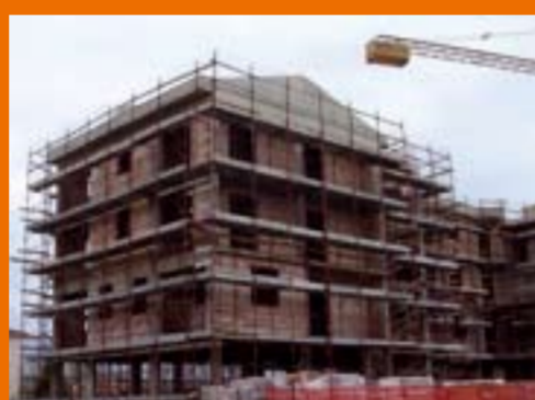
FIGLINE VALDARNO, VIA FRATELLI CERVI 18 alloggi - in corso di riappalto
