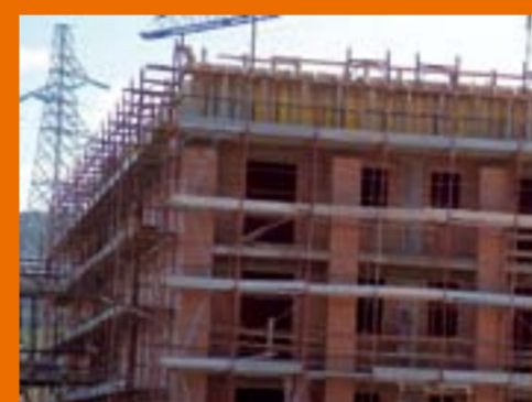
SESTO FIORENTINO, CHINI, LOTTO N. 1/A 39 alloggi - Impresa: AF Freda Costruzioni S.r.l. di Roma - ultimazione lavori a termini contrattuali: settembre 2007
