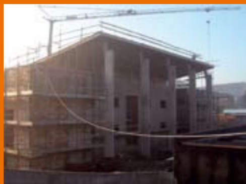
BARBERINO DI MUGELLO, CAVALLINA 12 alloggi - Impresa: Costructa S.r.l. di Caserta - ultimazione lavori a termini contrattuali: giugno 2007
