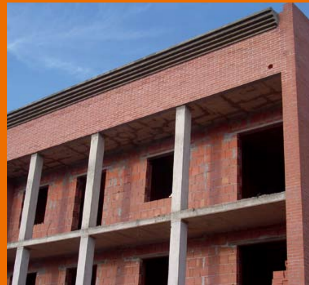
IMPRUNETA, VIA HO CHI MINH 8 alloggi - Impresa: Tecno Edil Costruzioni di Giuliano in Campania (NA) - ultimazione lavori a termini contrattuali: giugno 2007
