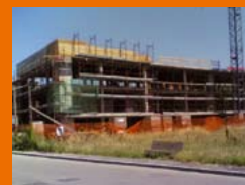
CERRETO GUIDI, STABIA 12 alloggi - Impresa: AF Freda Costruzioni S.r.l. di Roma - ultimazione lavori a termini contrattuali: luglio 2007
