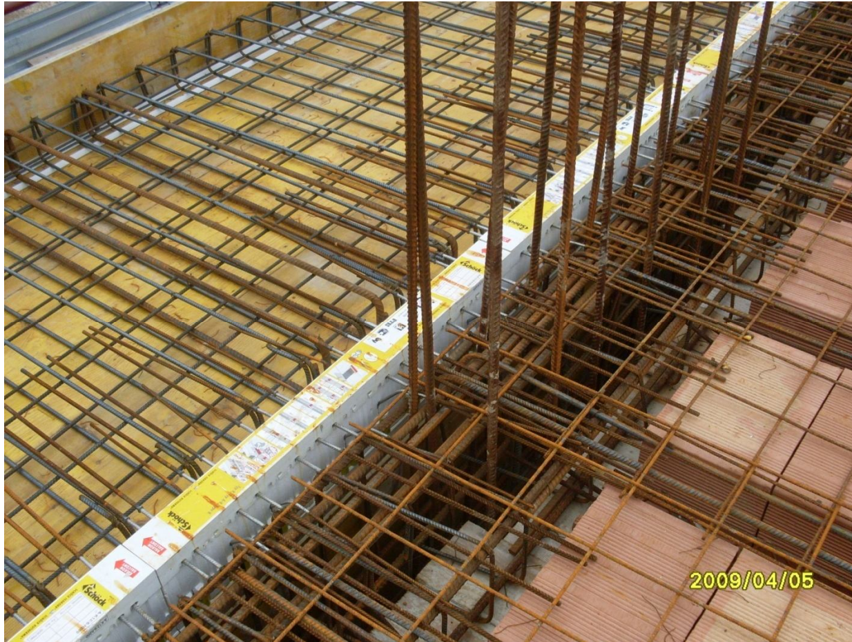
sistema a taglio termico per i balconi
