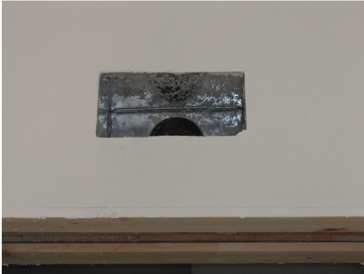
bocchette per estrazione aria
