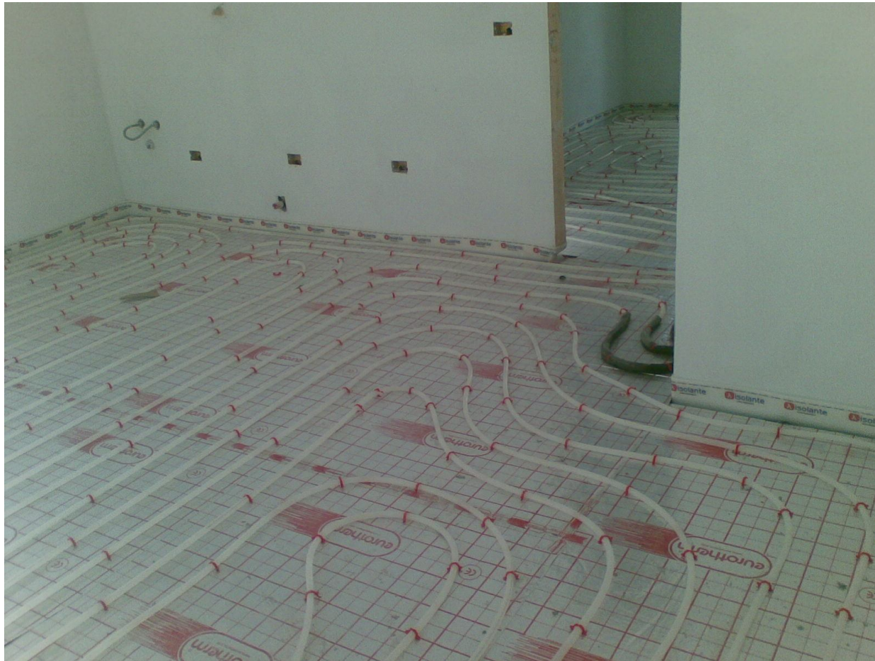
impianto di riscaldamento radiante a pavimento con lastra piana
