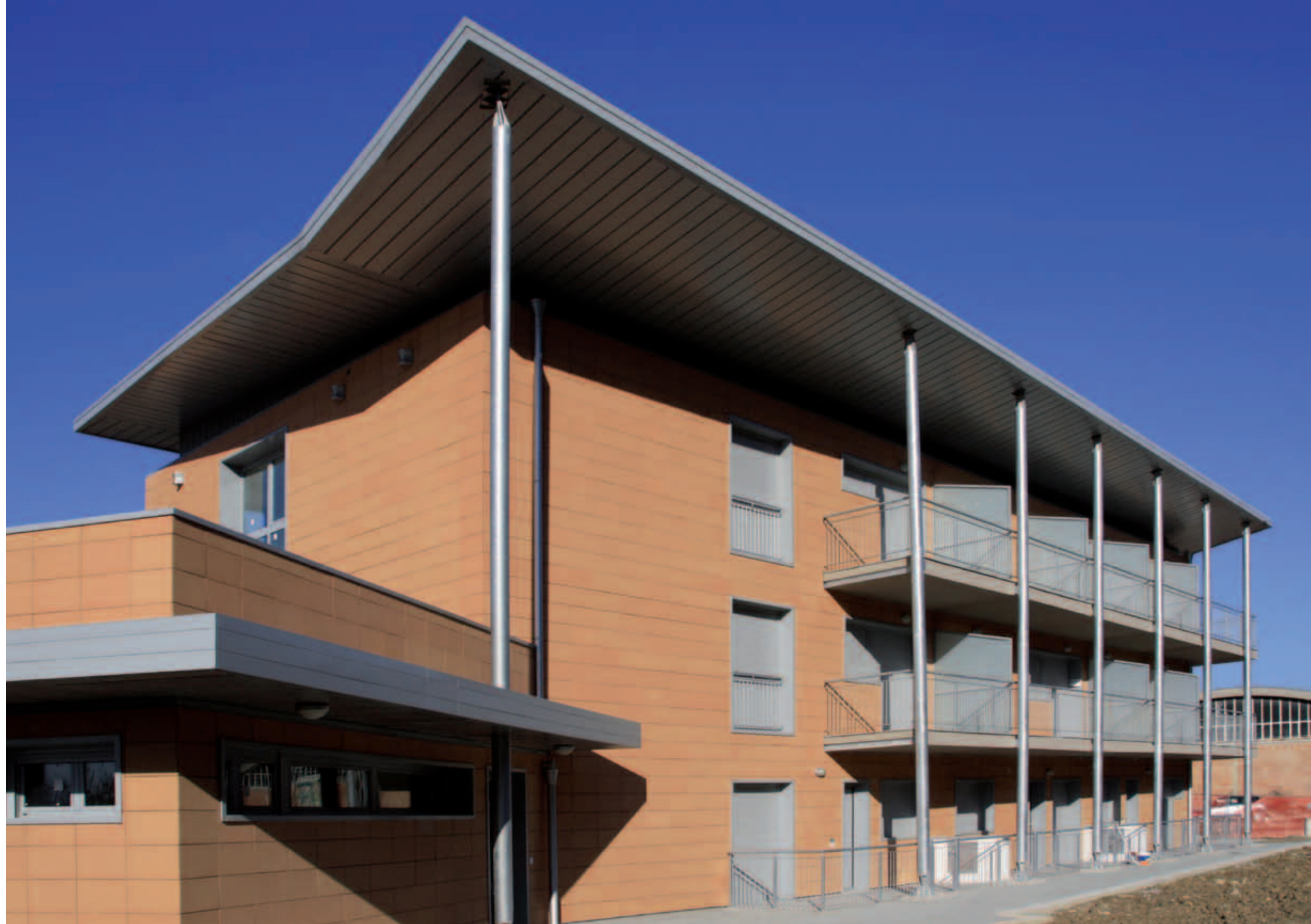
vista da sud del complesso edilizio
