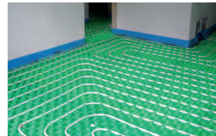
distribuzione del riscaldamento con pannelli radianti a pavimento
