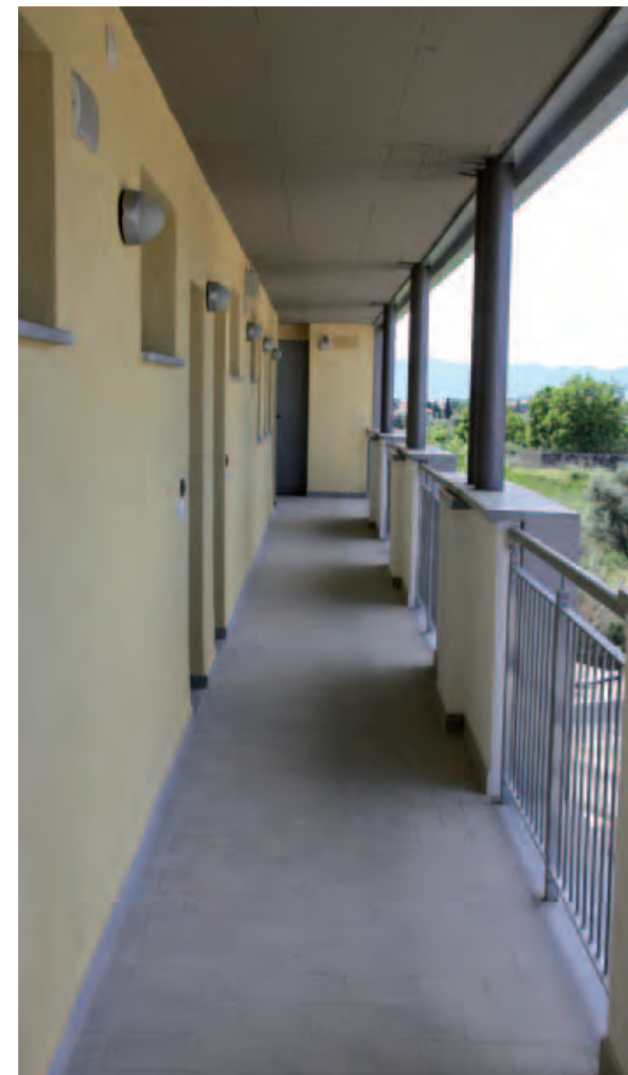
ballatoio di distribuzione
