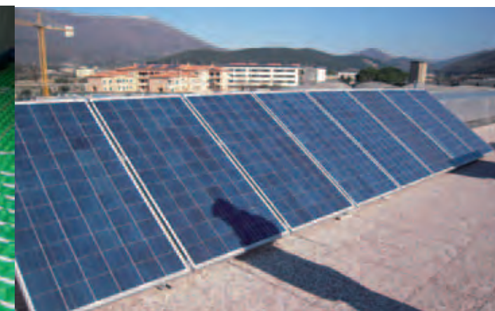
pannelli fotovoltaici per soddisfare i consumi condominiali
