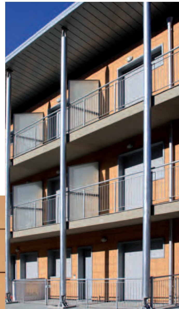
particolari del montaggio della parete ventilata
