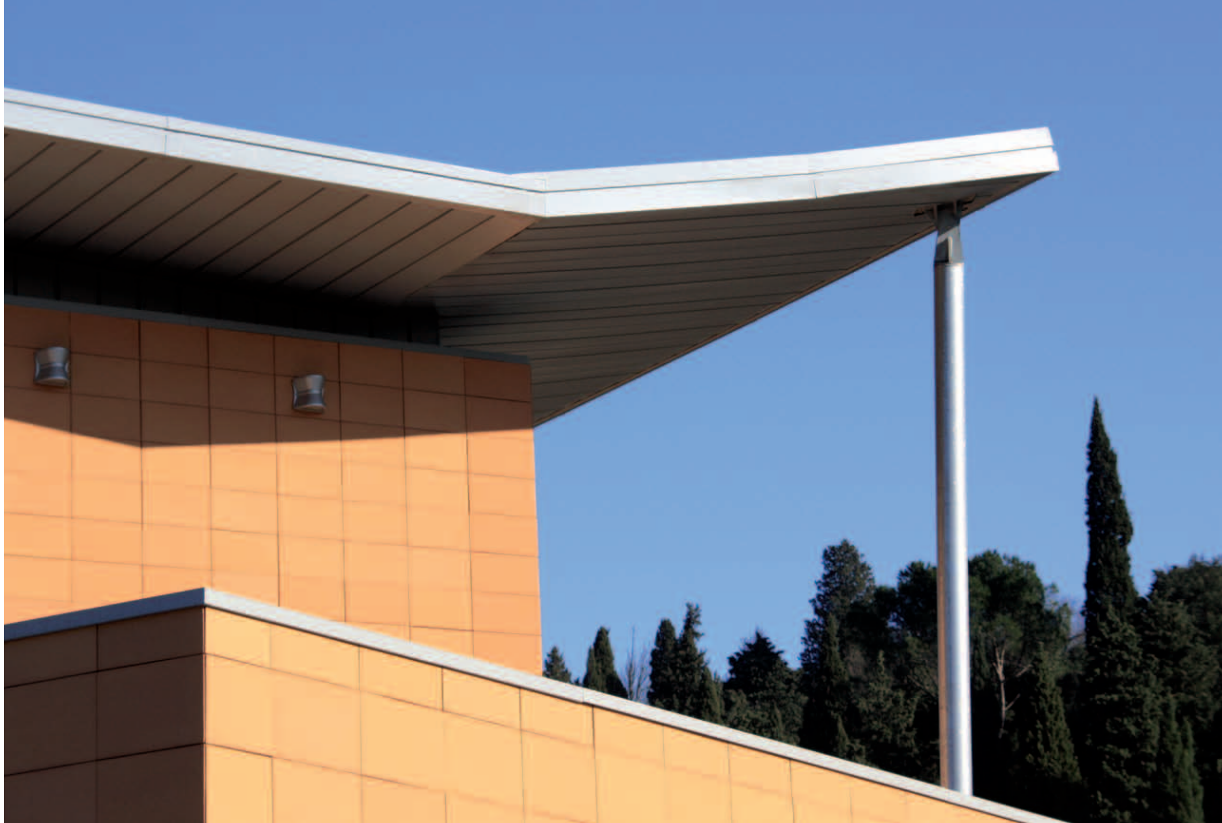
particolare della copertura
